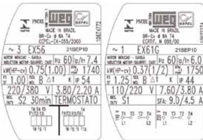
Figura 2.3 - Placa de identificación de motor para bomba de combustible
